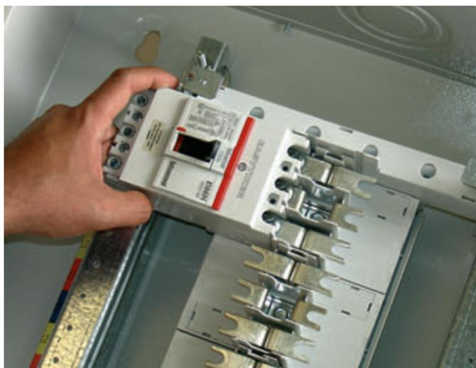
El diseño de los tableros permite configurar el tipo de acometida ya sea a Zapatas Principales o a Interruptor Principal, adaptándose a los requerimientos de instalación sin necesidad de cambiar el tablero.
