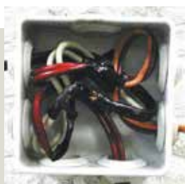
Instalación sin Nylbloc™
