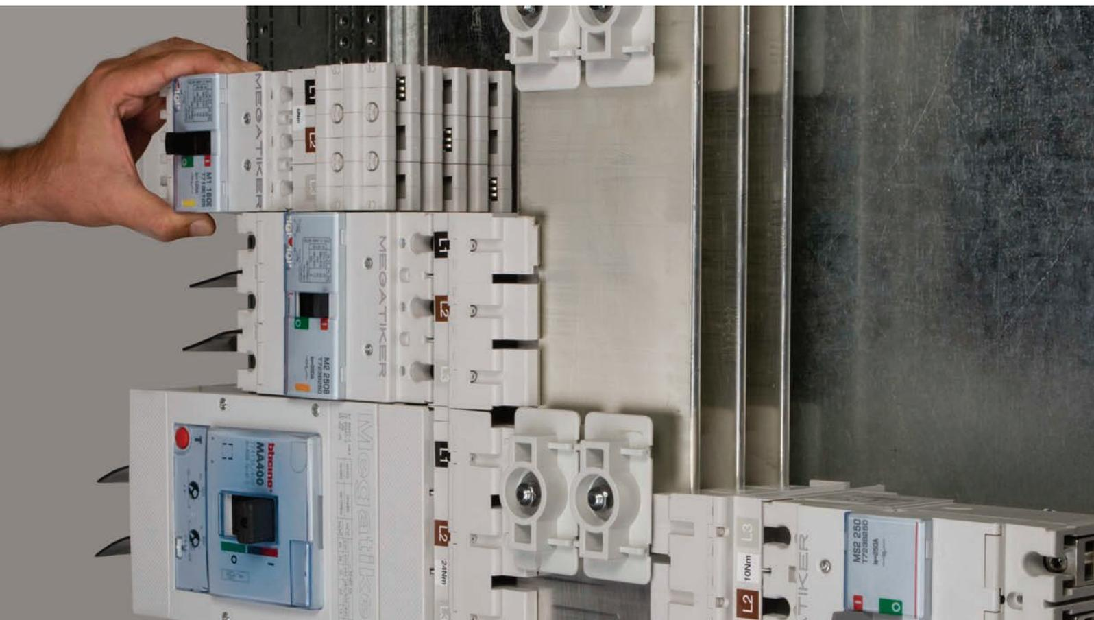
Para instalar los interruptores derivados en modo enchufable; basta asociarlos con el módulo enchufable correspondiente:
