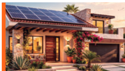
Granjas Fotovoltaicas Residencial
