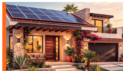
Granjas Fotovoltaicas Residencial
